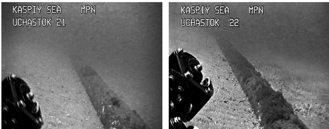
**Рис. 9** Ландшафт конечного участка трубопровода проходящего в зоне активной литодинамики
