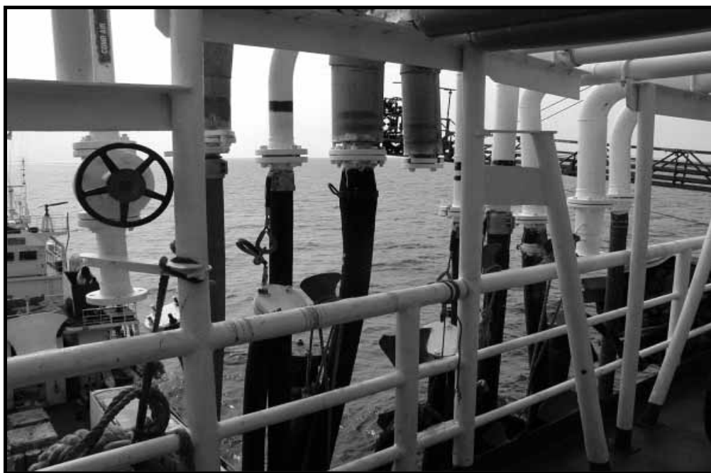
Рис.4.2 Система герметичного приема-выдачи жидких грузов на СПБУ «Астра».
